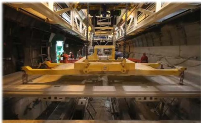
Tre carri ponte idraulici, realizzati su misura, opereranno in simultanea sulle tre zone di cantiere all'interno del traforo
